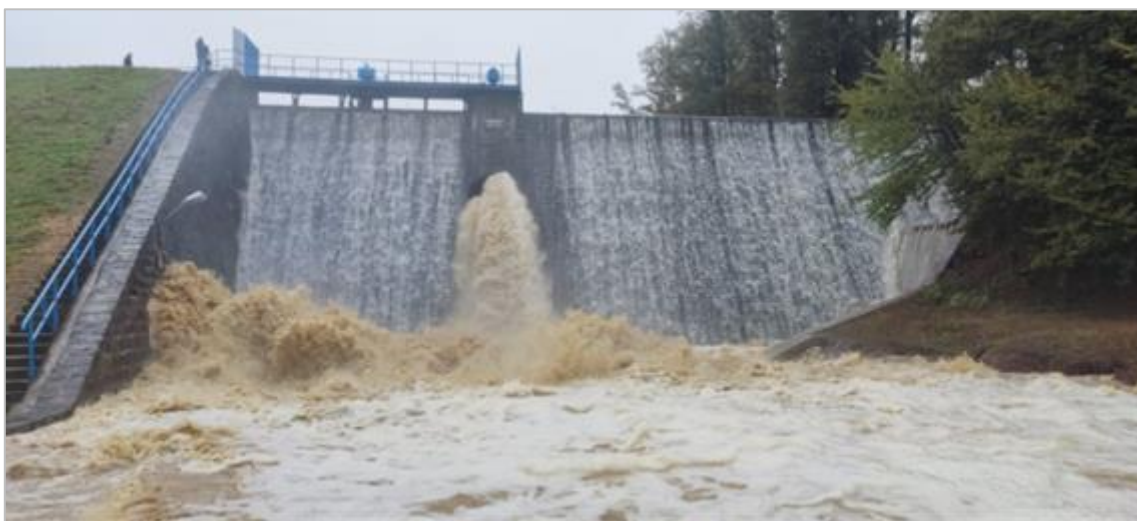
Rys. 3-1.2 Widok na dolne stanowisko zapory kamiennej w dniu 15.09.2024 r. (Źródło: Doraźna ocena bezpiecznego użytkowania obiektu budowlanego: Zbiornika przeciwpowodziowego na Żłotym Potoku w Jarnońtówku).
